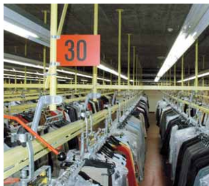
Das Textillogistikzentrum verfügt über eine fünf Kilometer lange Förderanlage.
